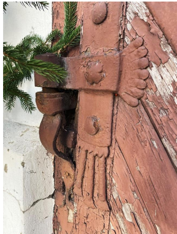
Fot. 2, 3, 4, 5. Stan wartwy malarskiej oraz elementów okucia drzwi wejściowych na elewacji frontowej, awers.
