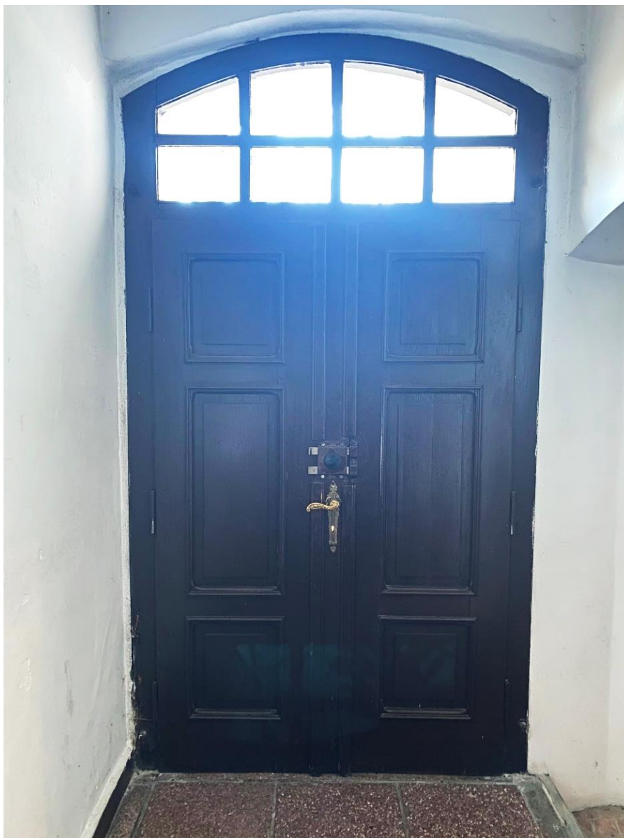
Fot. 9, 10. Drzwi wejściowe na ścianie bocznej – awers i rewers.
