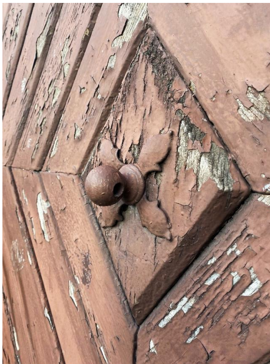
Fot. 2, 3, 4, 5. Stan wartwy malarskiej oraz elementów okucia drzwi wejściowych na elewacji frontowej, awers.
