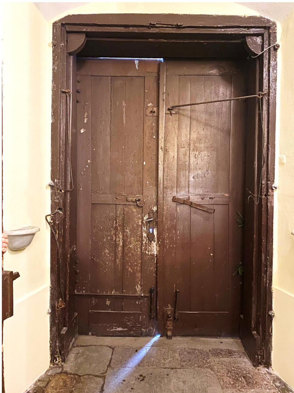
Fot. 6. Drzwi wejściowe na elewacji frontowej, rewers.
